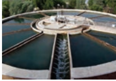
آب در تصفیه‌خانه
