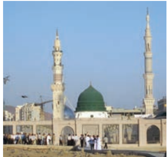
مسجد النبی، نمای بیرونی
